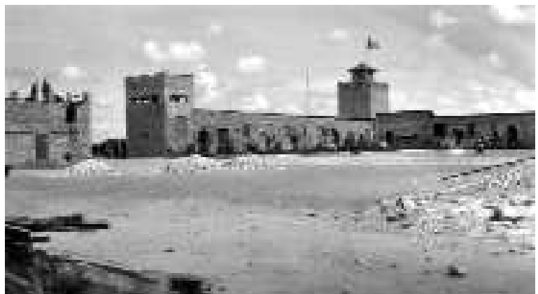
Vue générale du poste
