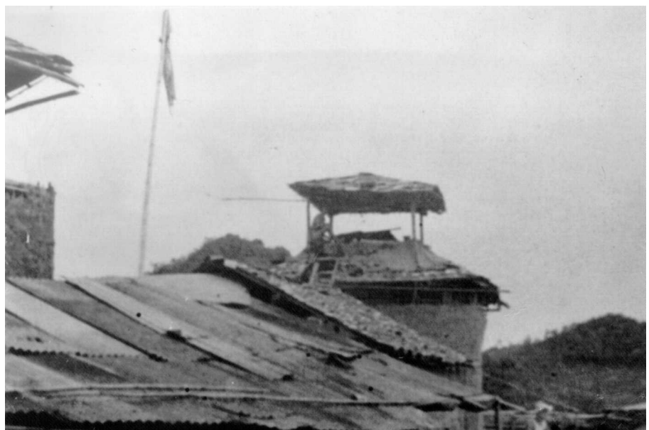
Poste de Bo-Cung : les deux coins du poste. Au premier plan la tour de la 20 mm flak ; au centre, la tour de la 12,7 mm qui avait été transférée quelques jours auparavant l'attaque dans les calcaires situés entre cette tour et le mat des couleurs.
