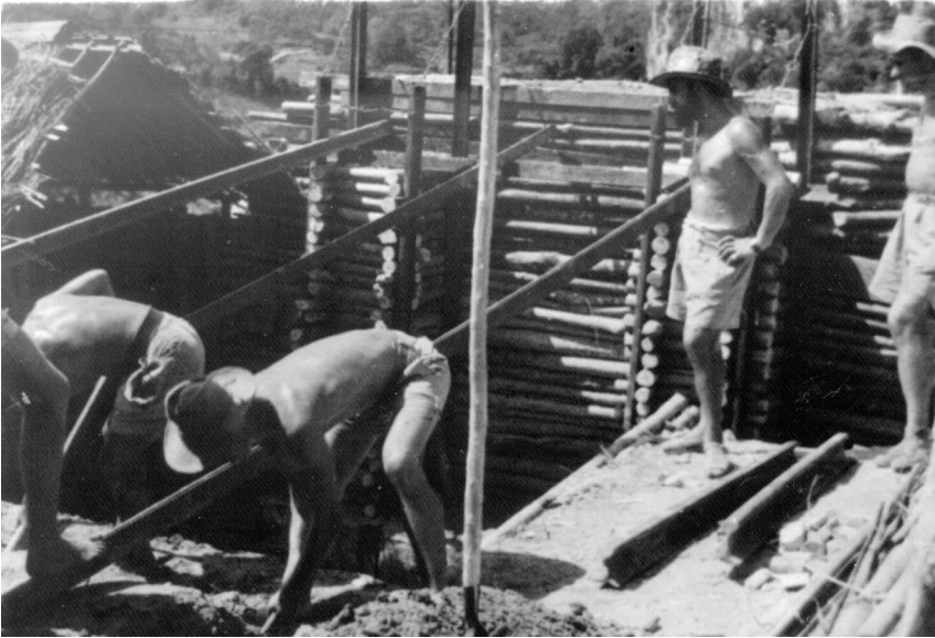
Face Nord-Est du poste de Bo-Cung, enterrement du logement des légionnaire en prévision d'une attaque. Lieutenant JALUZOT et Caporal-chef ONYPTCHUK ou ORUPPTDUX
